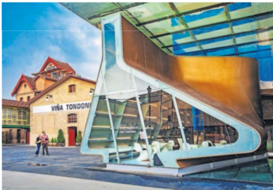
Las instalaciones de López de Heredia, en Haro, con la tienda proyectada por la arquitecta Zaha Hadid. / GONZALO AZUMENDI
