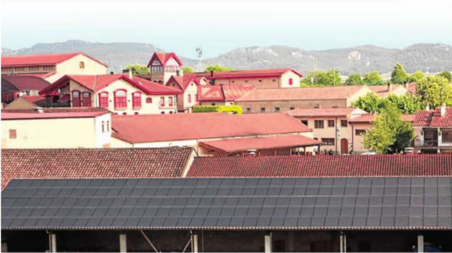
En la base de la imagen, y con la arquitectura de otras bodegas de La Estación al fondo, los paneles fotovoltaica de Muga. :: EL CORREO
